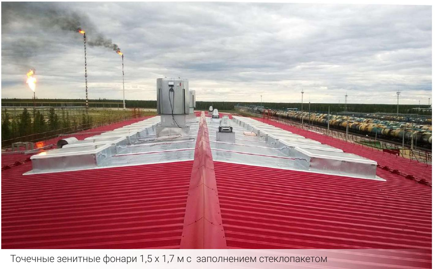
Точечные зенитные фонари 1,5 x 1,7 м с заполнением стеклопакетом
