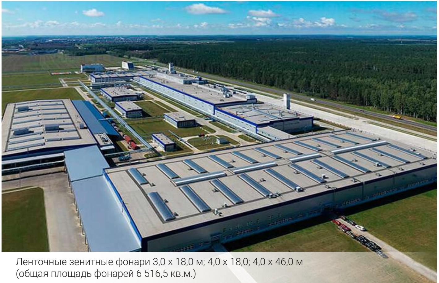
Ленточные зенитные фонари 3,0 x 18,0 м; 4,0 x 18,0; 4,0 x 46,0 м
