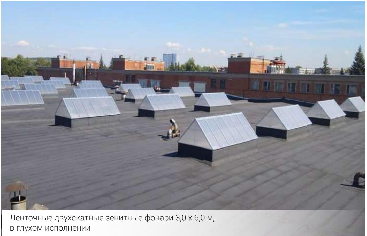
Ленточные двухскатные зенитные фонари 3,0 x 6,0 м,
